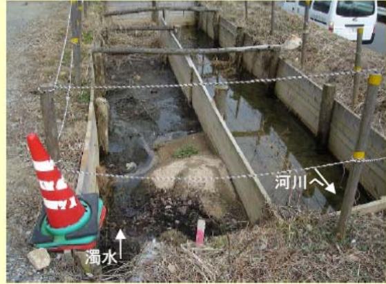
仮設沈砂池の設置
