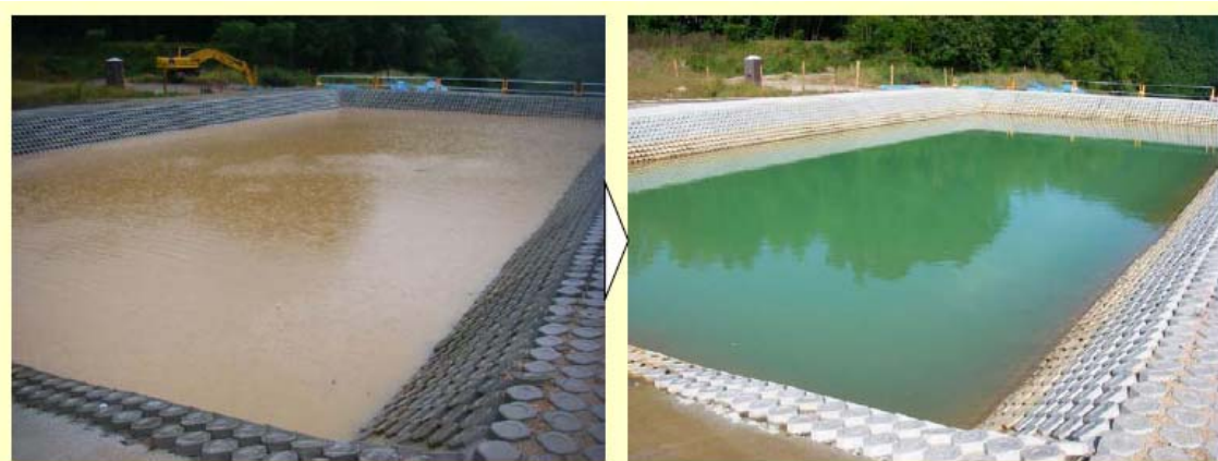
土砂により濁った水を一旦、沈砂池に溜めて、
