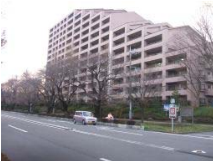
写真 1 問題となった大学通り沿いのマンション
