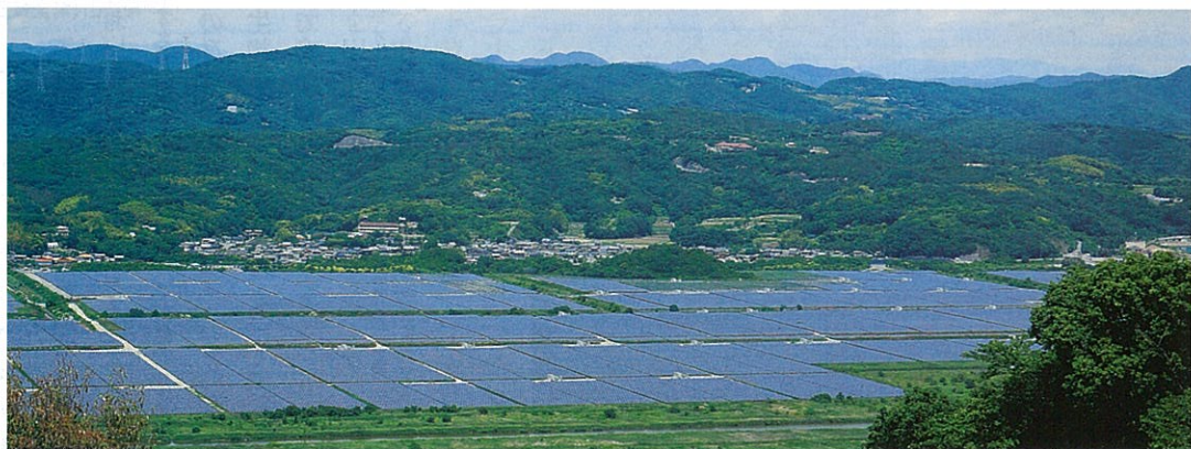
錦海塩田跡地発電パネル設置状況
