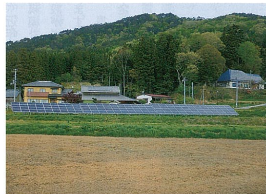
写真2 放射性物質により汚染された耕作放棄地に建設された太陽光発電施設（飯館村、2017年5月）
