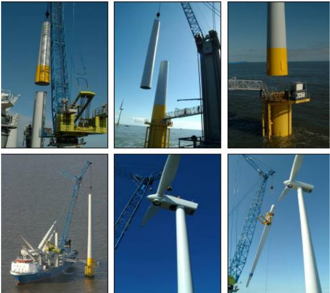
風力発電機の据付作業
