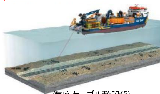
海底ケーブル敷設(5)
