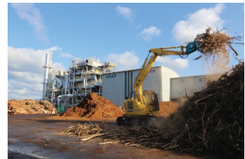
地域の未利用材を活用 宿毛バイオマス発電所(高知県宿毛市)
