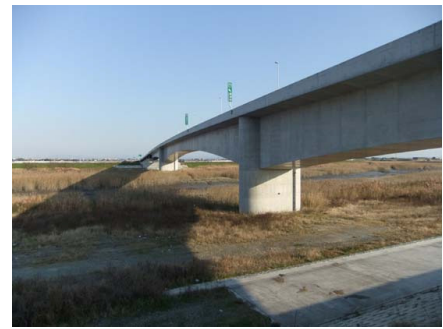
動植物に配慮した嘉瀬川の橋脚
