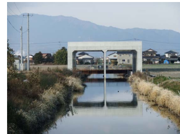
クリーク現状保存のためのボックスカルバート
