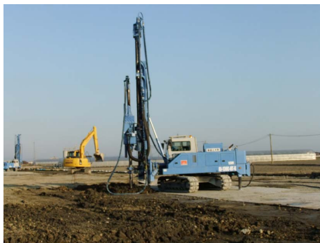
地盤改良の状況
