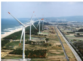
写真 北条砂丘風力発電所
